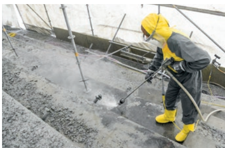
Санирование бетона
